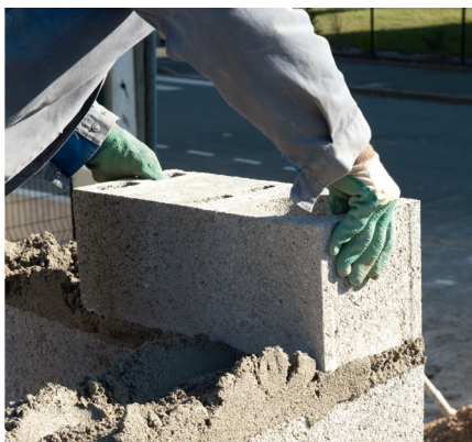
Maçonnerie de blocs
